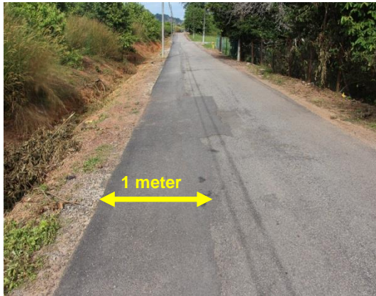
Gambar 1.26 Kerja Pelebaran Jalan Bernilai RM65,000 Yang Tidak Dibuat Secara Sebut Harga
