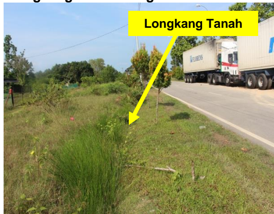
Gambar 1.42 Longkang Tanah Yang Tidak Dibersihkan
