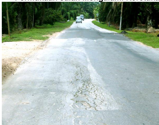
Gambar 1.1 Permukaan Jalan Mengalami Keretakan Dan Garisan Jalan Tidak Di Cat Semula
