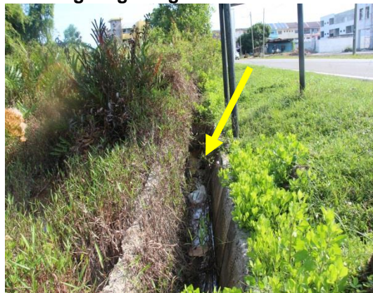
Gambar 1.43 Longkang Yang Tidak Dibersihkan
