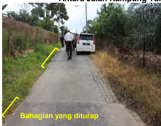
Gambar 1.24 Antara Jalan Kampung Yang Disenggara Secara Patching
