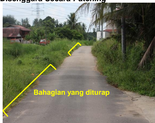
Gambar 1.24 Antara Jalan Kampung Yang Disenggara Secara Patching
