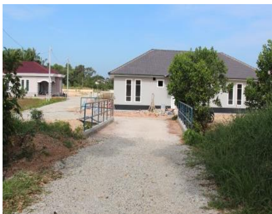
Gambar 1.17 Jambatan Yang Dibina Bukan Di Jalan Pertanian (Kos RM19,800)
