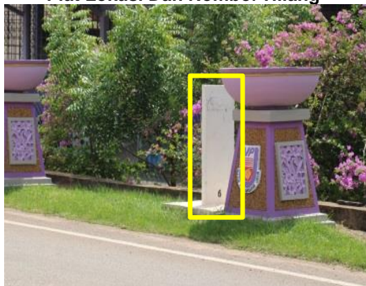
Gambar 1.29 Kilometer Post Yang Terlindung Serta Plat Lokasi Dan Nombor Hilang
