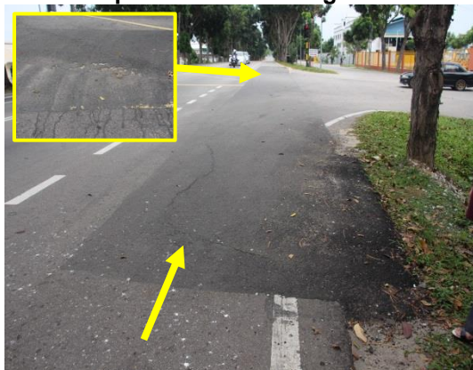
Gambar 1.39 Turapan Semula Kurang Memuaskan Dan Garisan Jalan Tidak Dicat Semula
