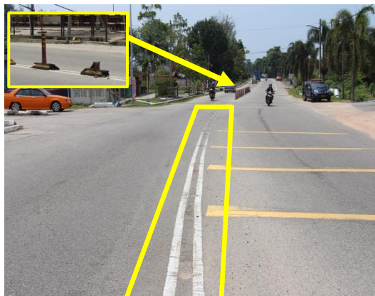
Gambar 1.30 Flexible Road Divider Rosak Dan Hilang
