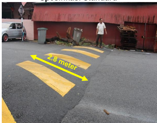
Gambar 1.27 Lebar Bonggol Tidak Mengikut Spesifikasi Standard
