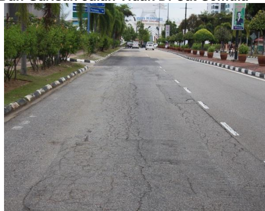
Gambar 1.1 Permukaan Jalan Mengalami Keretakan Dan Garisan Jalan Tidak Di Cat Semula
