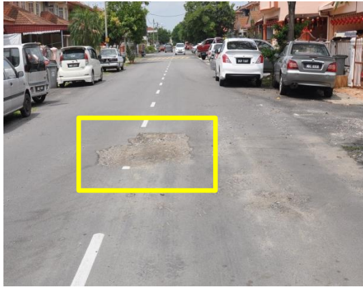
Gambar 1.41 Jalan Yang Tidak Diturap Semula
