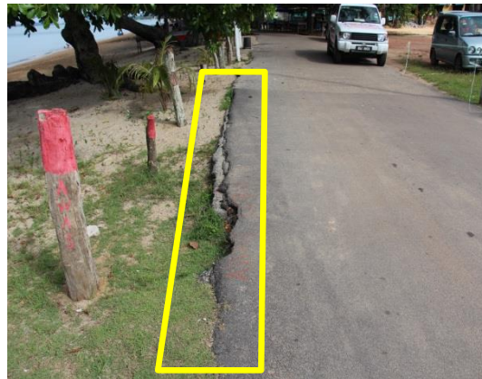
Gambar 1.21 Kerosakan Tepi Dan Bahu Jalan Rendah
