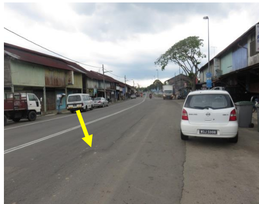
Gambar 1.39 Turapan Semula Kurang Memuaskan Dan Garisan Jalan Tidak Dicat Semula
